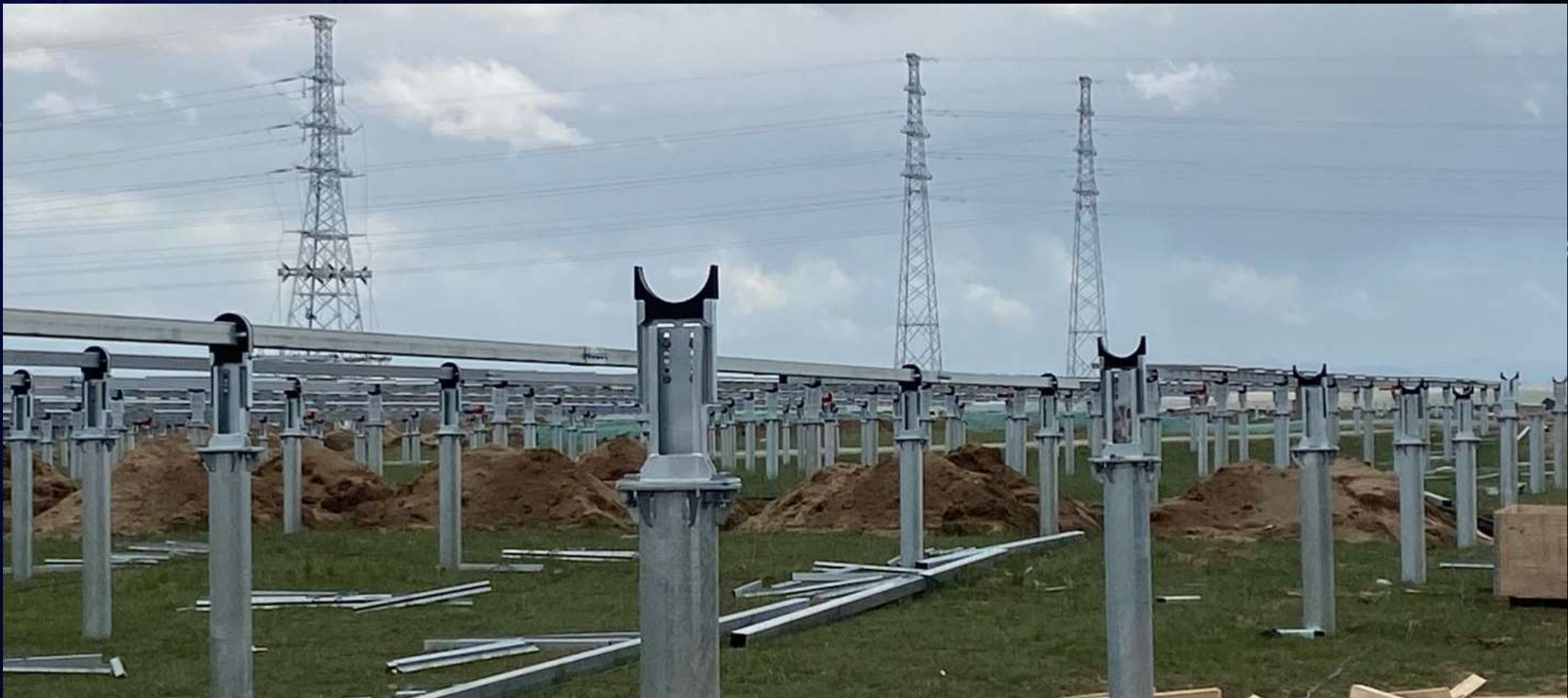
天合优配分体式球形轴承设计高效安装
