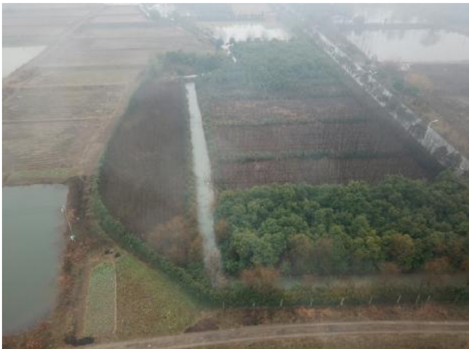
升压站-位于苗圃园内
