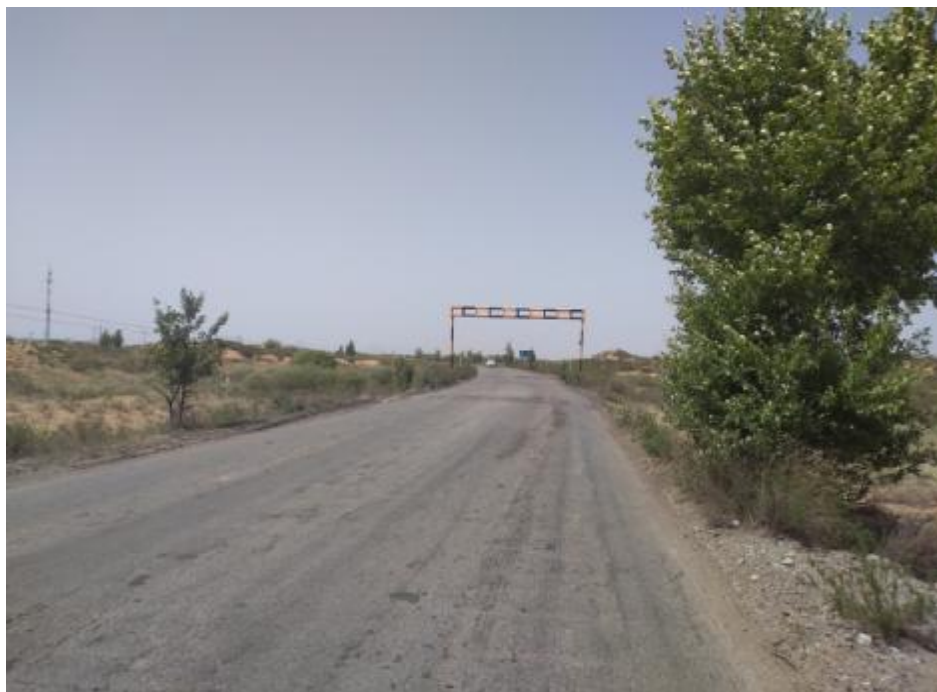
进场道路勘验
