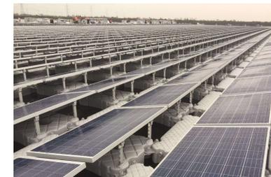
等高中空设计，最大限度的降低PID效应，增加发电量
